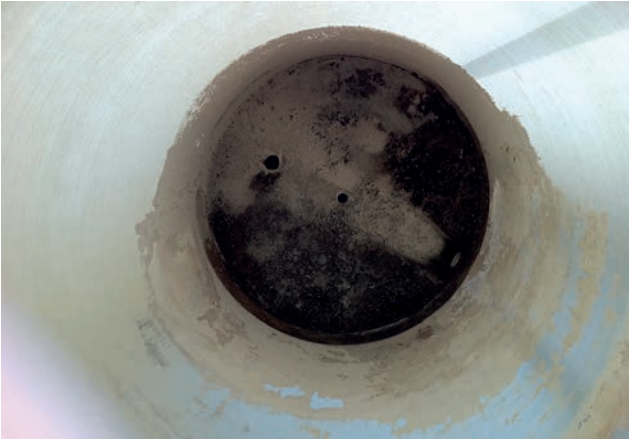
Abb. 54: Bei ca. 80 % der Silos bilden sich im oberen Bereich Ablagerungen, welche ein optimaler Nährboden für Schimmelpilze und andere Mikroorganismen darstellen. Die Gefahr, dass frisches Futter damit kontaminiert wird und zu gesundheitlichen Problemen der Tiere führen kann, ist groß. (Quelle: U. Gonsch)
