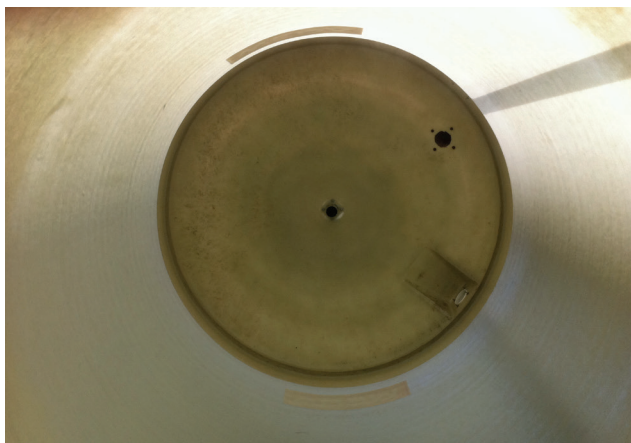
Abb. 55: Bei einer ordnungsgemäßen Reinigung und Desinfektion der Futtersilos werden alle alten Ablagerungen entfernt und vorhandene Mikroorganismen abgetötet. Somit kann die volle Qualität des frisch zugeführten Futters ausgeschöpft werden. (Quelle: U. Gonsch)
