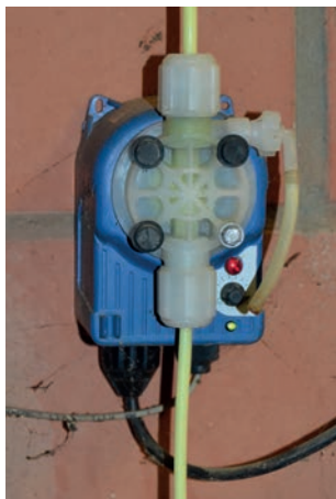
Abb. 64: Um den rückwertigen Keimeintrag langfristig und effektiv zu verhindern, sollte eine kontinuierliche Tränkwasserdesinfektion (z. B. mit Chlordioxid) erfolgen. Wichtig ist, immer vorher abzuklären, ob das Desinfektionsmittel für das jeweilige Wasser geeignet ist. (Quelle: P. Münster)
